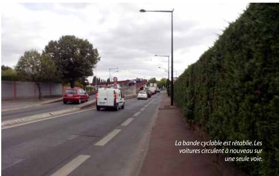
En prévision des travaux sur l'autopont de la place Latule, la bande cyclable avait été supprimée pour que les voitures circulent sur deux voies.
