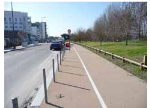
La nouvelle piste de Marcel-Dassault est trop étroite. L'espace piéton tout à côté est trop étroit et encombré de poteaux de signalisation qui rabattent les piétons sur la piste.
