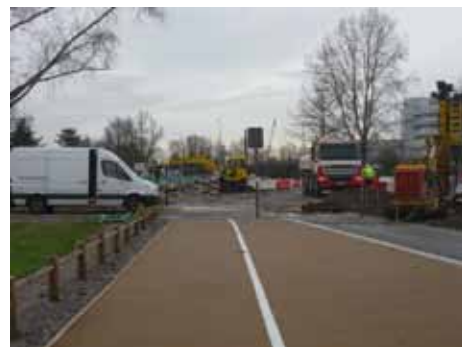
La nouvelle piste cyclable disparaît sous les travaux. Va t-elle renaître de ses cendres ou s'arrêter définitivement ici ?
