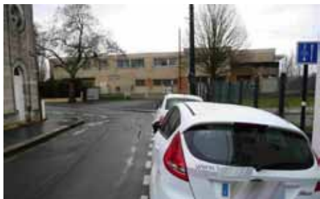
Aménagement du virage serré rue Fauché
