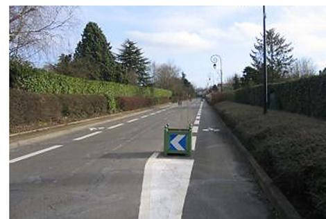
Un chaucidou, ou chaussée à voie centrale banalisée
