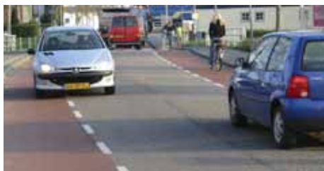
Chaussée à voie centrale banalisée
