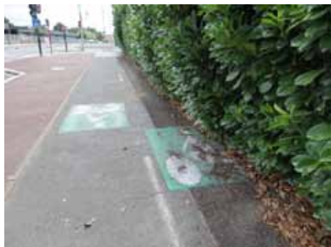
C'est la piste qui est mal positionnée ou la haie mal taillée ?
