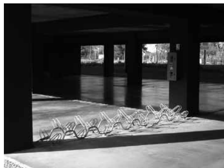
L'exemple des bureaux du Tasta à Bruges. Des accroche-roues mal placés, aucun local fermé, utilisation nulle.
