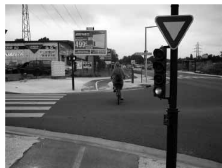
Blanquefort-Bruges, une bonne liaison cyclable intercommunale.
