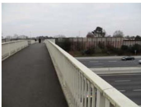
Passerelle de Pessac Monbalon
