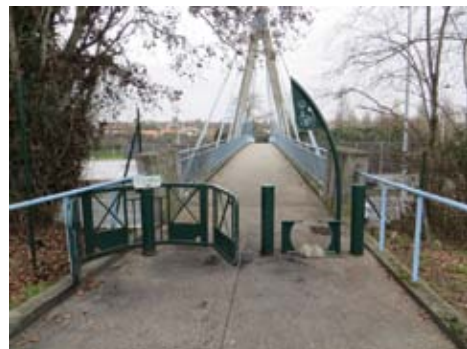
Passerelle de Lormont
