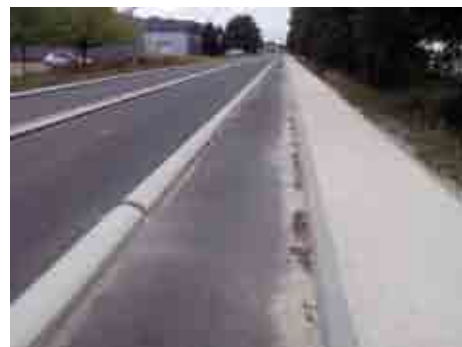
Après la rocade, l'avenue de Magudas, en direction de Saint-Médard en Jalles a été réduite à deux voies, bordées de bandes cyclables protégées par un rebord de béton.
