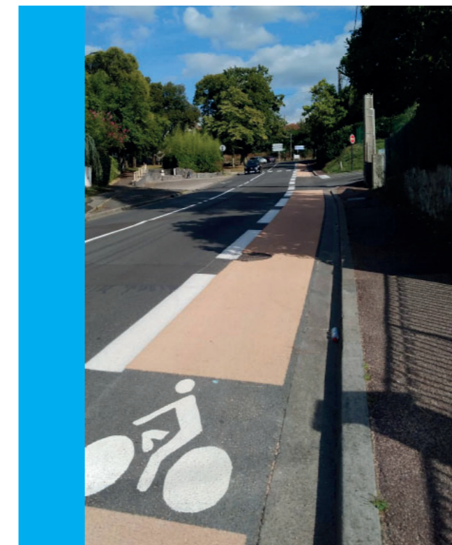
▲ Très redoutée pour sa pente "accentuée", la rue du Maréchal-Foch à Cenon se voit désormais dotée d'une bande cyclable.
